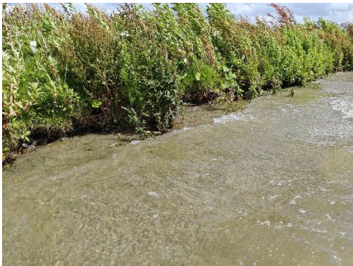
Afbeelding 8 - Oever erosie met ondiepte
